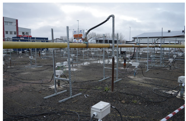
Termisk sanering av klorerade lösningsmedel.
