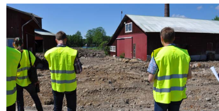
Schaktsanering vid Hjortsberga sågverk.
