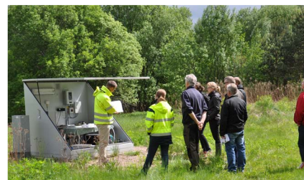
Station för skyddspumpning, Daniel Glatz på Hifab berättar om hur det går till.
