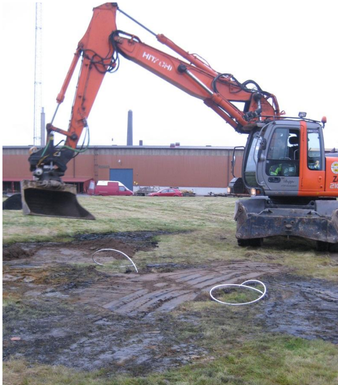
Bild 2.5: En av grönlutslamsgroparna (grop 1) efter återfyllnad, de vita plastslangarna är uppumpningslang från lysimetrarna. Foto Maria Mäkitalo.
