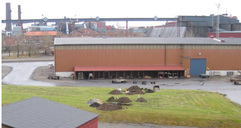
Bild 2.2: Utsikt över området med flygaska som tätskikt (grop 3 är närmast i bild och grop 4 är längst bort i bild). Vy mot sydöst. Foto Maria Mäkitalo.
