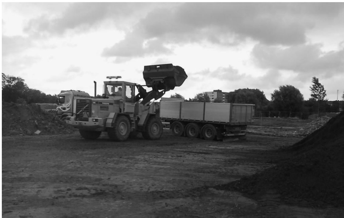
Figur 5-5. Lastning av förorenade massor, Lomma Hamn
