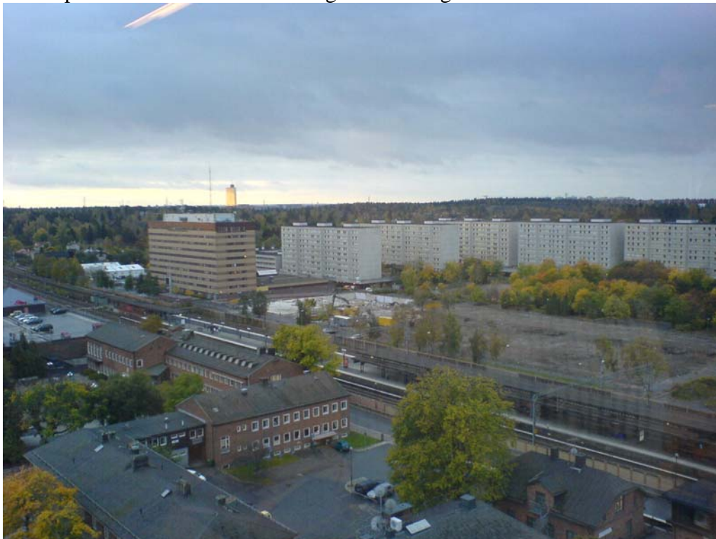
Bilder på Kv Tabellen – efter rivning av Turebergsskolan
