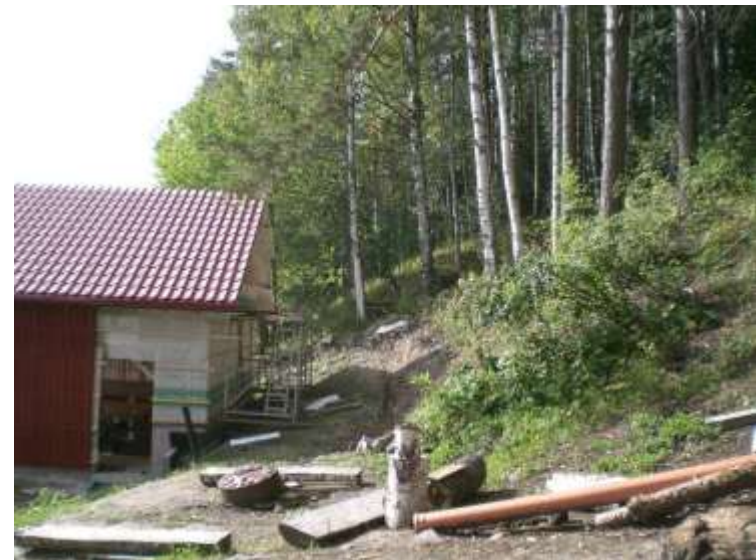
Schakt i släntfoten bakom nyuppförd uthusbyggnad
