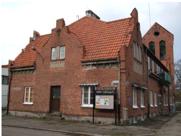
Det gamla kontoret med utställning och föreläsningssal. Byggnaden skall eventuellt bevaras. I bakgrunden syns "vattentornet".
