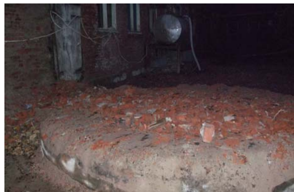
Resterna av den 65 m höga skorstenen.
