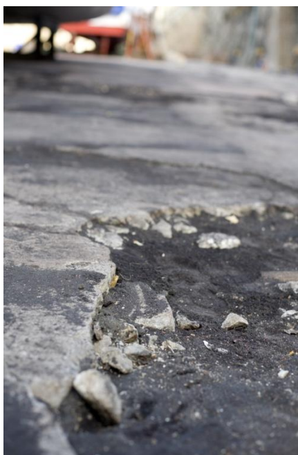
Bild 4. GV dockans betongbotten efter sopning. Foto: Dick Lyhammar.
